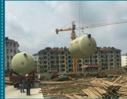
上海仁信 建筑安全工程有限公司合作项目
