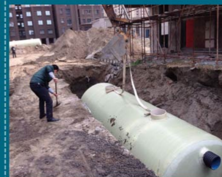
中国核建二四建设小区 污水治理工程
