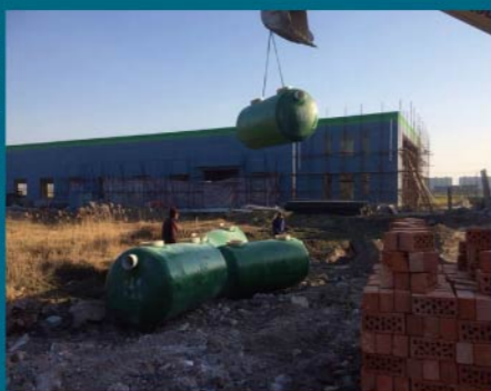
南通海安雅周 工业园区厂房工程项目
