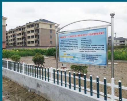
慈溪周巷三江口村 生活污水180T项目
