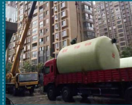
泰达青筑 南京污水合作项目
