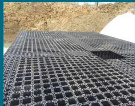
安徽合肥 徽盐世纪广场项目
