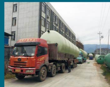
松阳县赤三村 大型无动力污水处理设备
