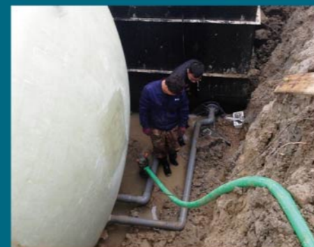
鸣鹤古镇 污水一体化PPP项目
