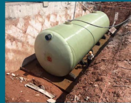
萧山经济开发区 污水治理PPP工程
