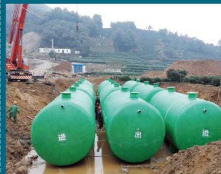
杭州西湖区龙坞镇 五水共治项目1
