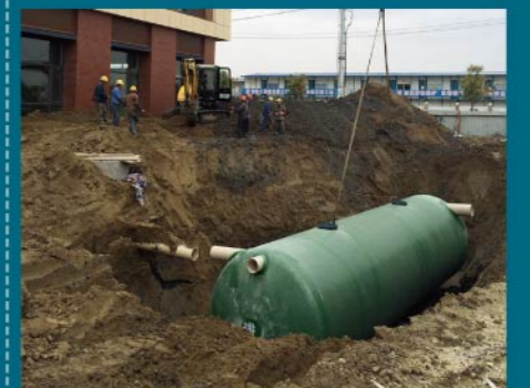
中国医药城医疗器械区 标准厂房项目
