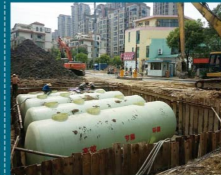
绍兴上马褚镇 污水处理一体化项目
