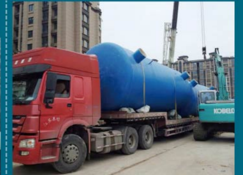
元力集团·望湖国际小区 污水建设工程
