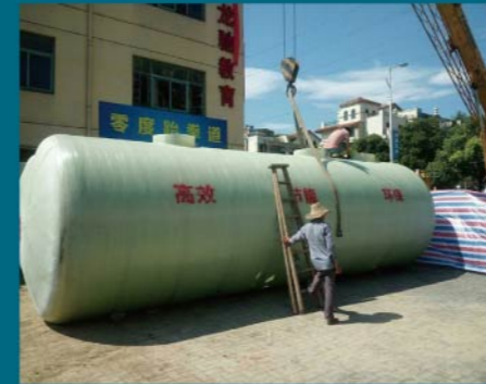
上虞舜水华庭小区 排洪蓄水池埋设项目
