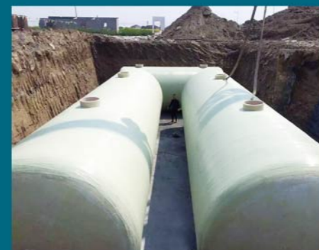
泰州市新城 居民区中水回用工程
